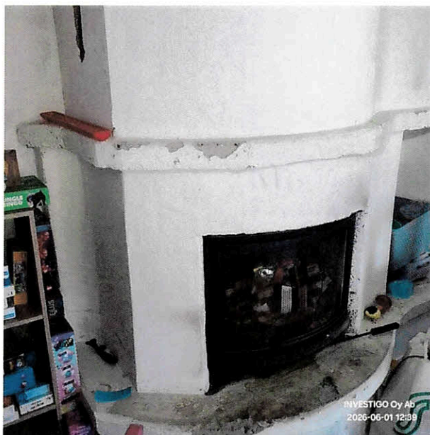
43. Eldstad finns i vardagstum. Enligt husägare har denna inte använts på en par år nu. Sotning bör göras för säkerhets skull. Oklart om kommunen slutsynat eldstad eller ej. Vi rekommenderar att sotare tillkallas att kontrollera eldstad innan den tas i bruk nästa gång.
