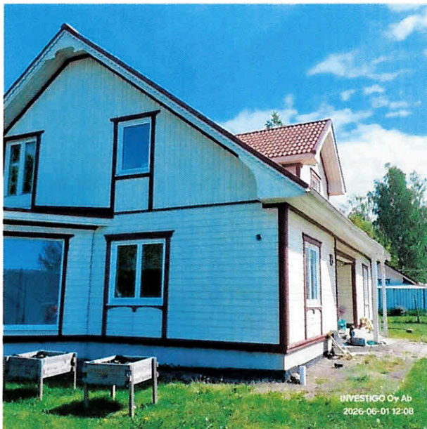
30. Översiktsbild fasader söder och väst.
