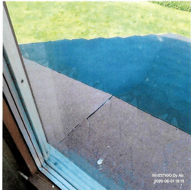
7. Filttaket halvfärdigt ovanför burspråket.
