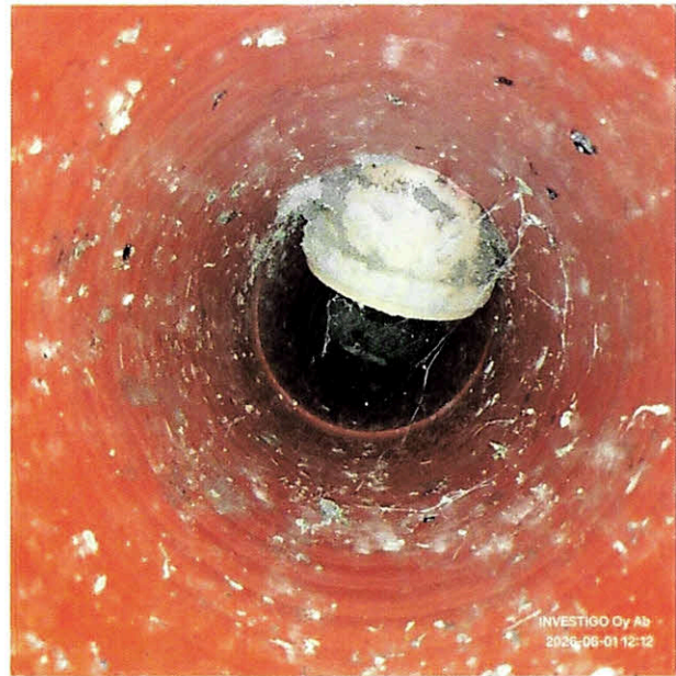
23. Finns en kontrollbrunn på framsidan. Ingen överflödigt vattennivå, indikerar att täckdikning fungerar åtminstone. Kan dock ej säga utifrån detta titthål hur omfattande dräneringen är dragen runt huset.
