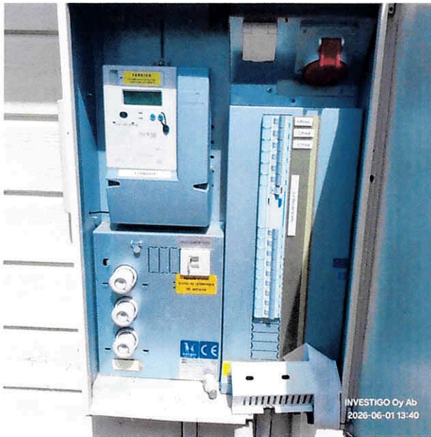
47. Elmätare och huvdsäkring sitter på garagaget vid infarten. Mätarställning vid granskningstillfället var 230 243 kWh. Mätaren stämplad med år 2015.
