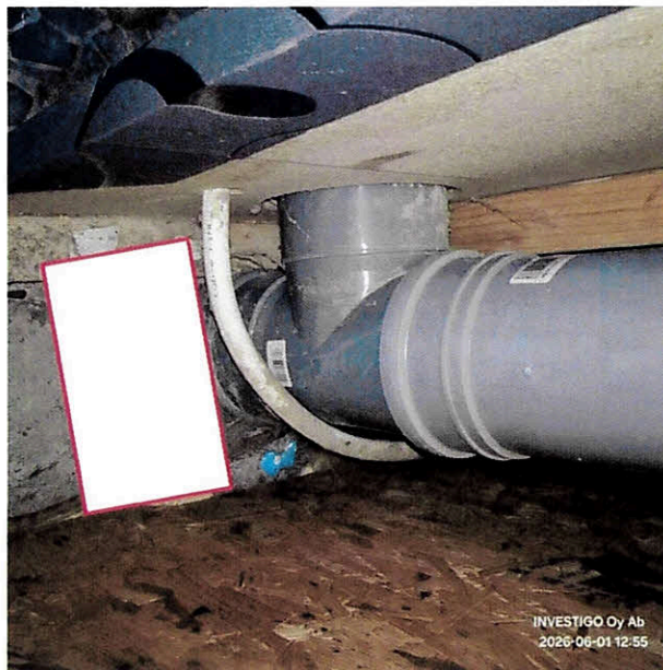
74. Insyn bakom WC-stol. Inga tecken på läckage kunde observeras.
